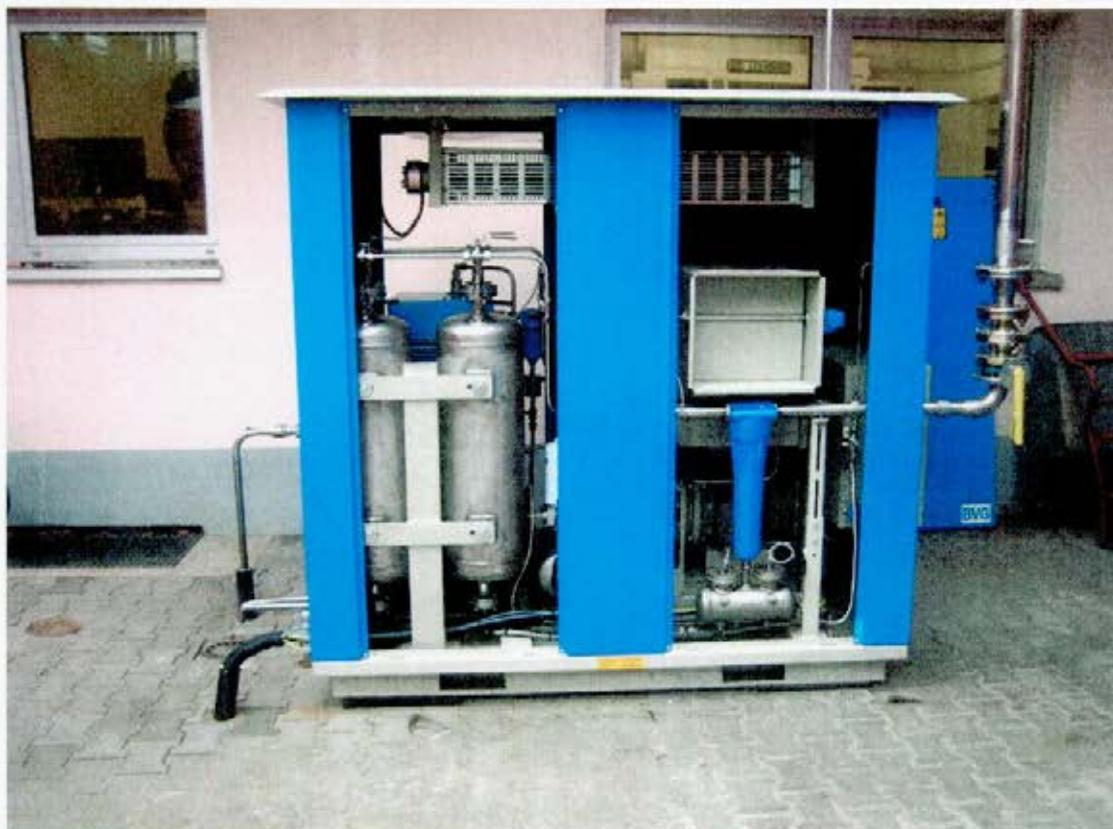
**Abbildung 7 Mikrogasturbine mit nachgeschaltetem Wärmetauscher**
